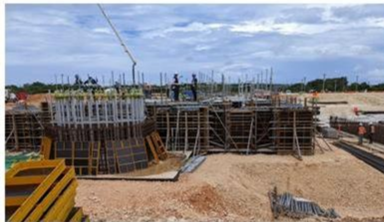
HRSG (#3 of 3) Foundation Pouring
