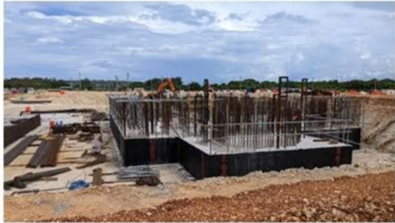
HRSG (#1 of 3) Rebar work
