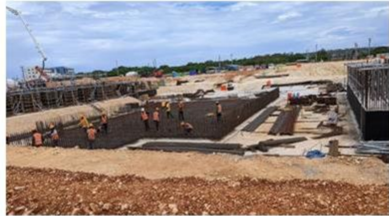
HRSG (#2 of 3) Rebar work
