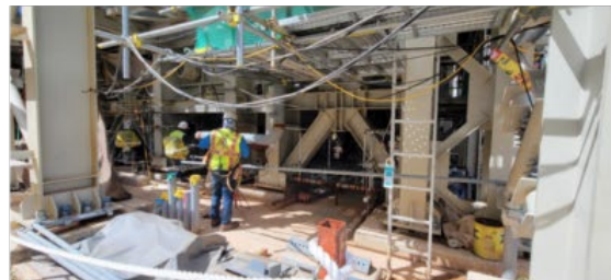
Piping installation is ongoing below HRSG #3
