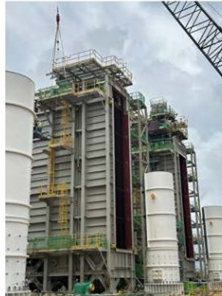
HRSG 1-3: Platform installation ongoing
