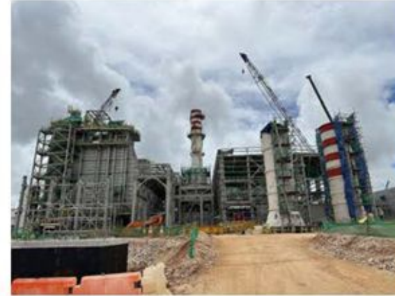
HRSG 1-3: Platform installation ongoing
