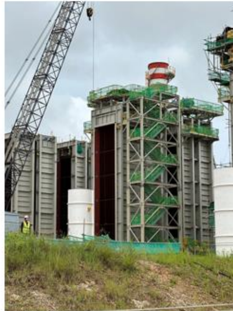
HRSG 1-3: Platform installation ongoing
