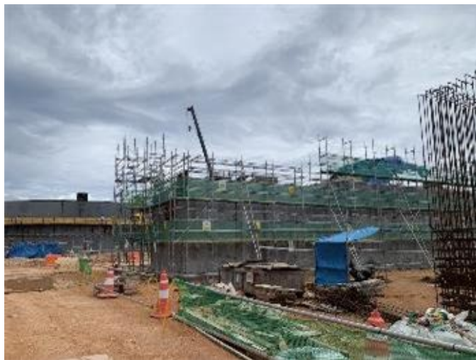
Fuel Pre-Treatment Bldg– Concrete pour for walls complete
